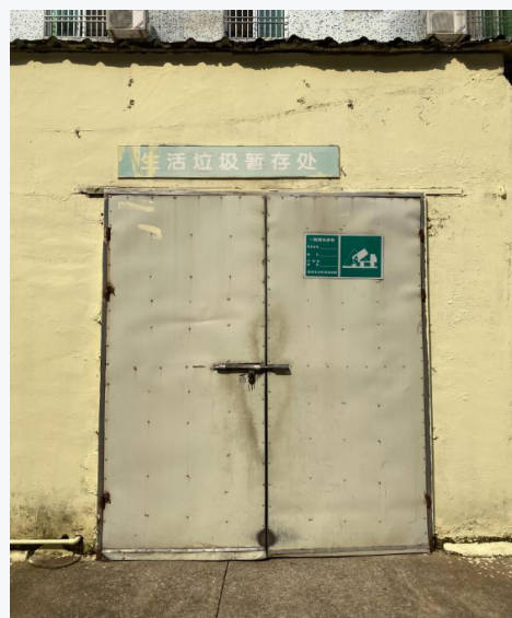
一般固废暂存间
