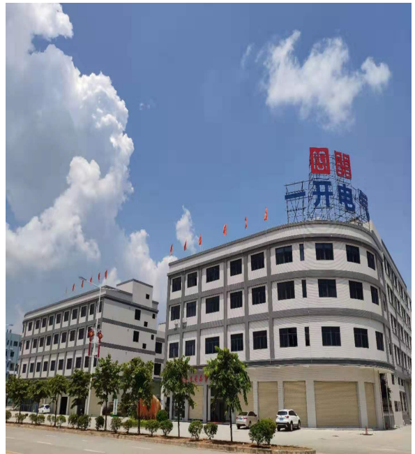
项目南面一开电器公司
