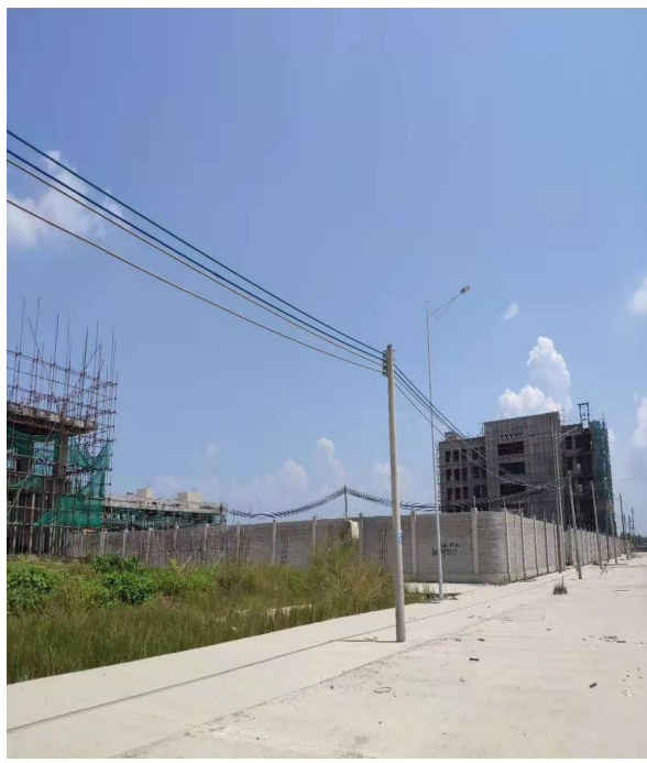
项目东面在建厂房工地
