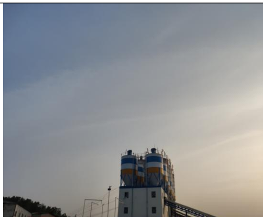
项目西面—建嘉混凝土公司
