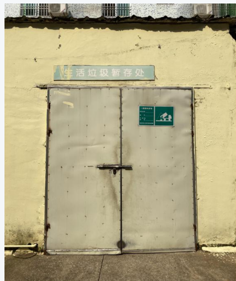
一般固废暂存间
