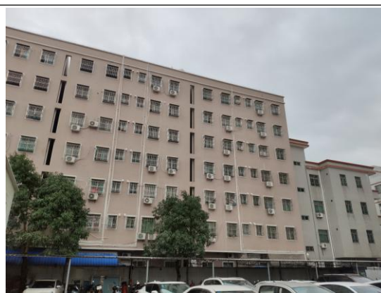
项目南面——居民区
