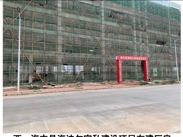
西，海丰县海迪尔家私建设项目在建厂房
