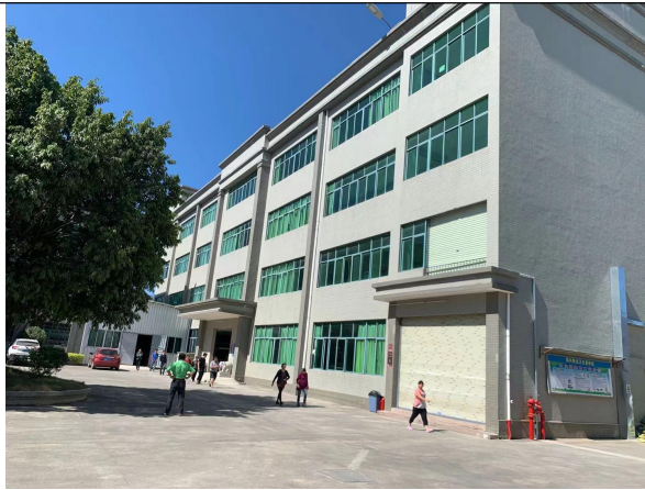
项目西面：翔兴鞋厂厂房
