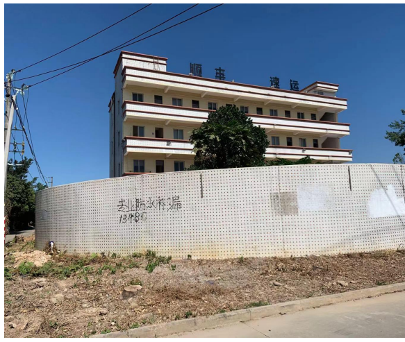
项目东面：顺丰速运仓库
